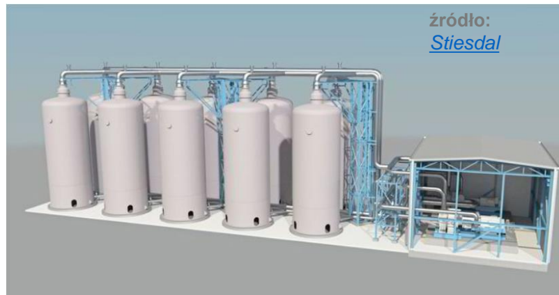
Długoterminowy magazyn energii cieplnej wykorzystujący „gorące skały”
