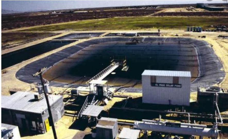
El Paso Solar Pond (USA), 3000m 2 , 3.2m depth
